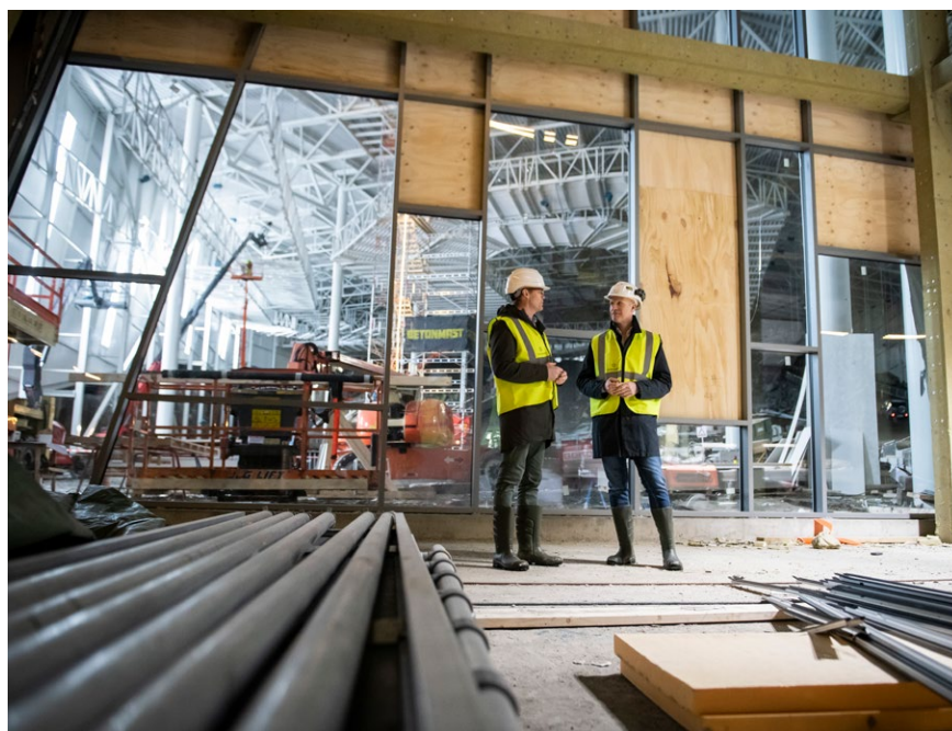
I RUTE: Det som i dag fremstår som en byggeplass, vil i 2020 åpne som verdens største innendørsanlegg for snøopplevelser. Jarle Aambø (til venstre) og Erik Hammer inspiserer fremdriften.
