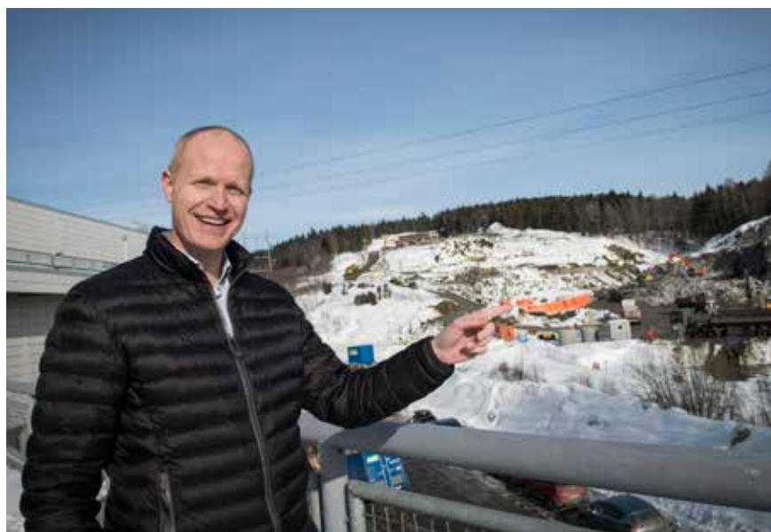
SKIHALLEN BYGGES: Byggingen av skihallen er i gang, og vil sikre snøopplevelser for store og små, proffe og amatører, året rundt.
